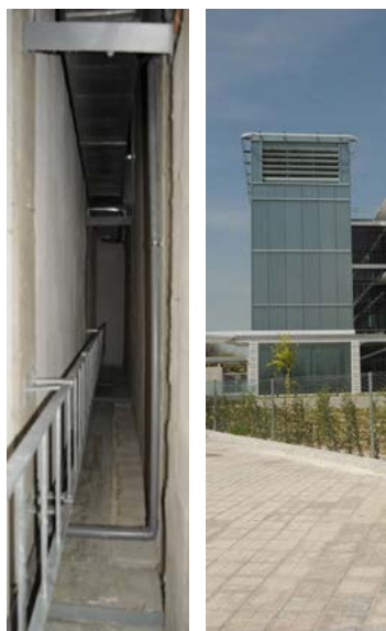
Izquierda: sistema de ventilación de emergencia. Colector vertical de extracción de aire para los almacenes 6, 18 y 24.
