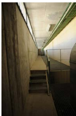
Ventilación de las cámaras de separación. Entradas de aire al nivel superior de la cámara oeste
