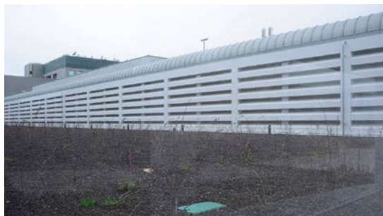
El bloque de instalaciones visto desde la galería del lateral Este del edificio. (Foto: Diego Martín. Filmoteca Española)
