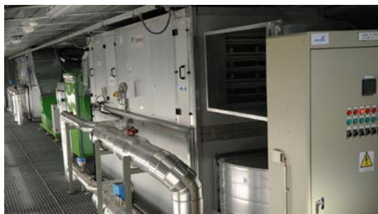
Bloque de instalaciones, planta primera. Climatizador nº 2 (archivos 3 y 4) con su correspondiente equipo de deshumectación. (Foto: Encarni Rus. Filmoteca Española)
