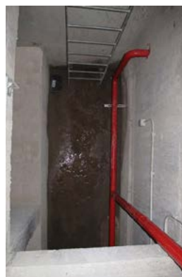
Ventilación de las cámaras de separación. Foso bajo el tercer sótano. Obsérvese el agua que circula por el fondo del sistema
