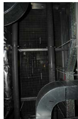
Ventilación de las cámaras de separación. Rejilla "Tramex" del piso de una planta en el patio interior para conductos de instalaciones
