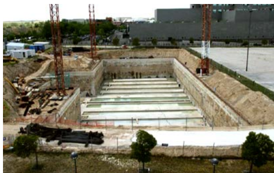
Inundación en la cimentación del CCR, en enero de 2010
