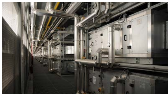
Bloque de instalaciones, planta baja. Climatizadores para la recirculación del aire en 34 almacenes. (Foto: Encarni Rus. Filmoteca Española)
