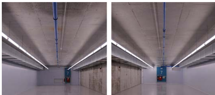
Sistema de ventilación de emergencia. Almacén nº 7. Compuertas en los lados Norte y Sur. (Foto: Encarni Rus. Filmoteca Española)
